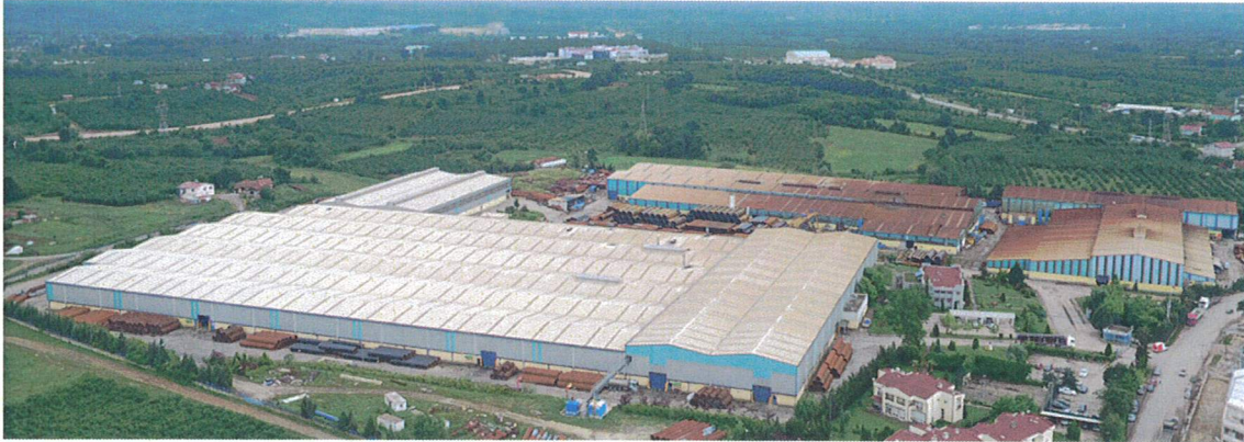
Görsel: Hendek Fabrika arazisi ve binası
